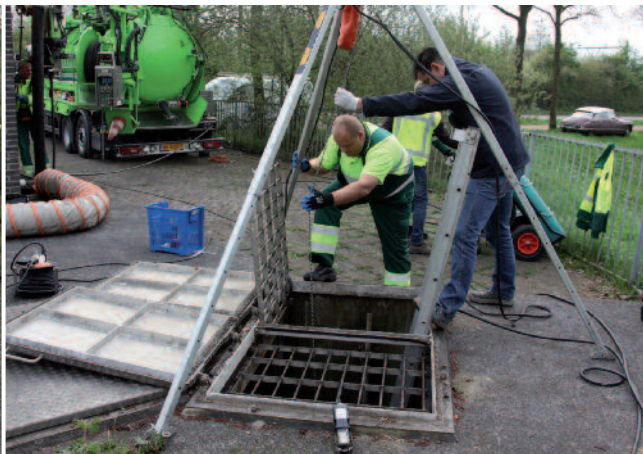
De atmosfeer in de kelder wordt continu bewaakt door de gepompte X-am 2500 (voorgrond) terwijl mangatwachten assisteren bij het afdalen en klimmen
