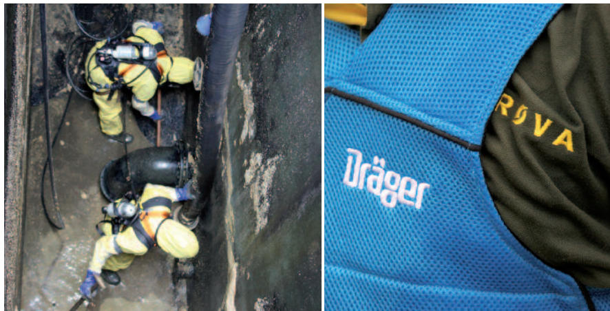
ROVA-helden Wellinga en Theunissen met Dräger-airline aan het werk in zes meter meter diepe rioolbunker
